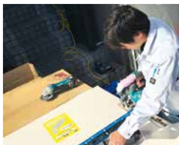
無駄を排除して生産性を高めた現場 (シティー・ジー・ネット)
